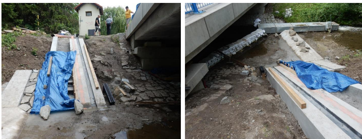
Obr. 5.4.2.3.3 Rekonstrukce stanice v Plaňanech v roce 2022
